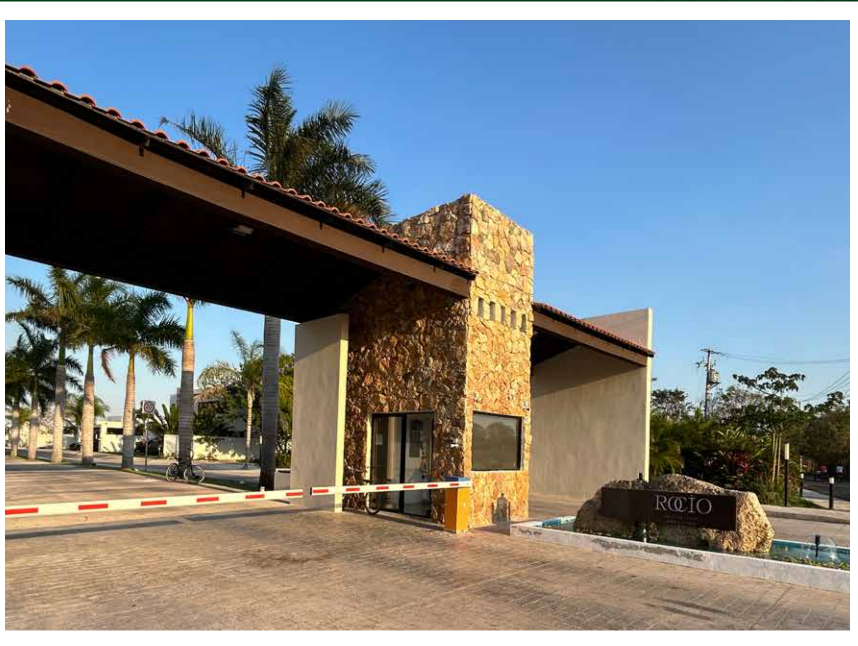
CONTROL DE ACCESO
