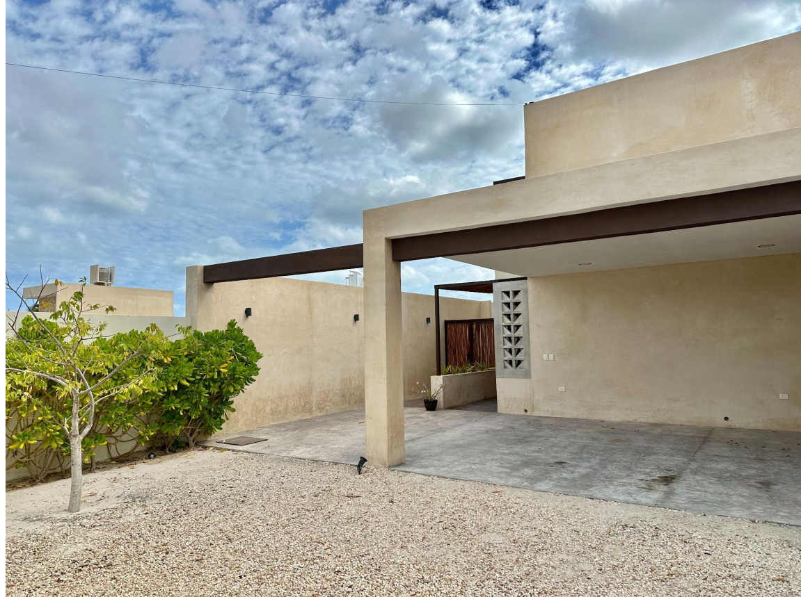
Garage techado para 4 autos, dos techados y dos atrás.
