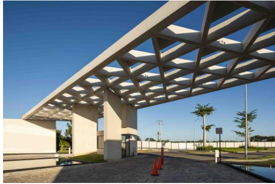
* Caseta de seguridad con acceso restringido
